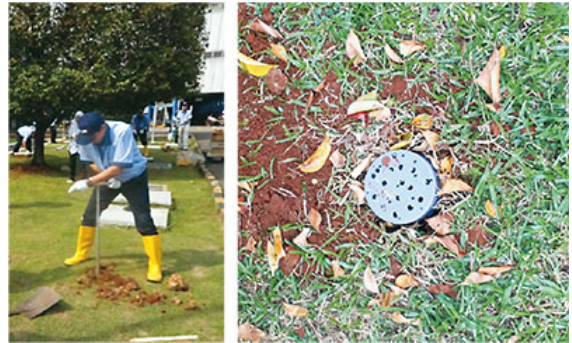
敷地内で穴を掘るIEIの社員と地中のバイオポア
