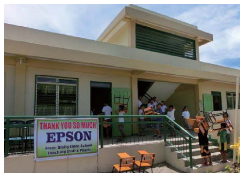
完成した新しい校舎
