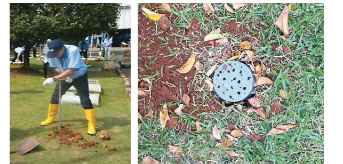
敷地内で穴を掘るIEIの社員と地中のバイオポア
