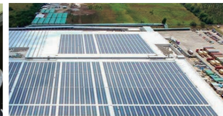
約3,000kWの最大出力を持つメガソーラー発電設備を備えたフィリピンの新工場(2017年)
