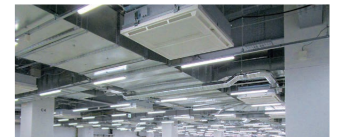
天井・壁の二重構造が不要で、空気の循環回数を減らす構造
