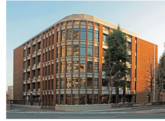
共創研究所が設置される産学連携先端材料研究開発センター (東北大学片平キャンパス)
