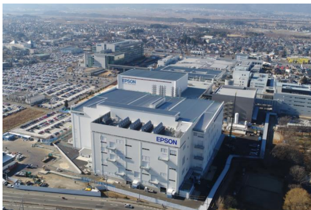
広丘事業所 新工場（9号館）
