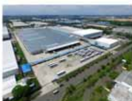
インドネシアエプソン新工場
