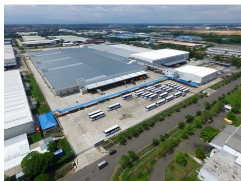
インドネシアエプソン新工場
