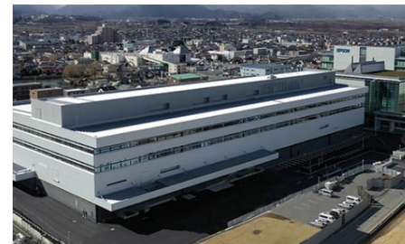
広島ソリューションセンター（長野県） （2020年春オープン）
